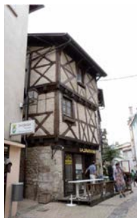
Fig.20 Patrimoine bâti urbain : maison de ville à colombage
