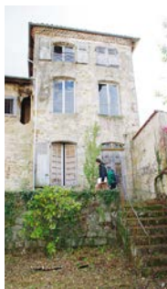
Fig.21 Maisons de ville vacantes qui ont pourtant des qualités
