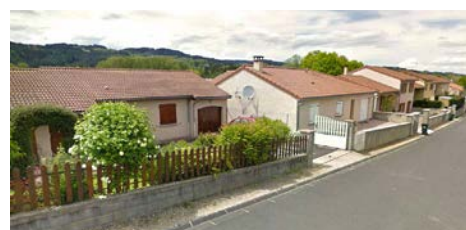
Fig.30 Lotissements en périphérie
